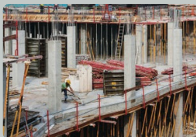
Công Trường Xây Dựng
